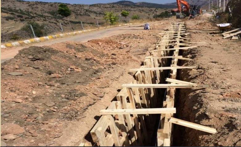
ÜNLÜPİNAR İÇMESUYU VE KANALİZASYON İNŞAATI
