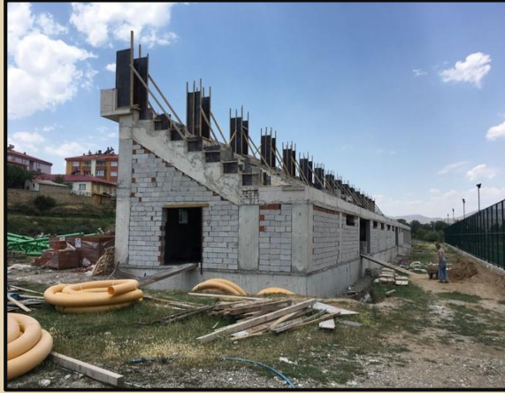
KELKİT 1000 KİŞİLİK BETONARME TRİBÜN
