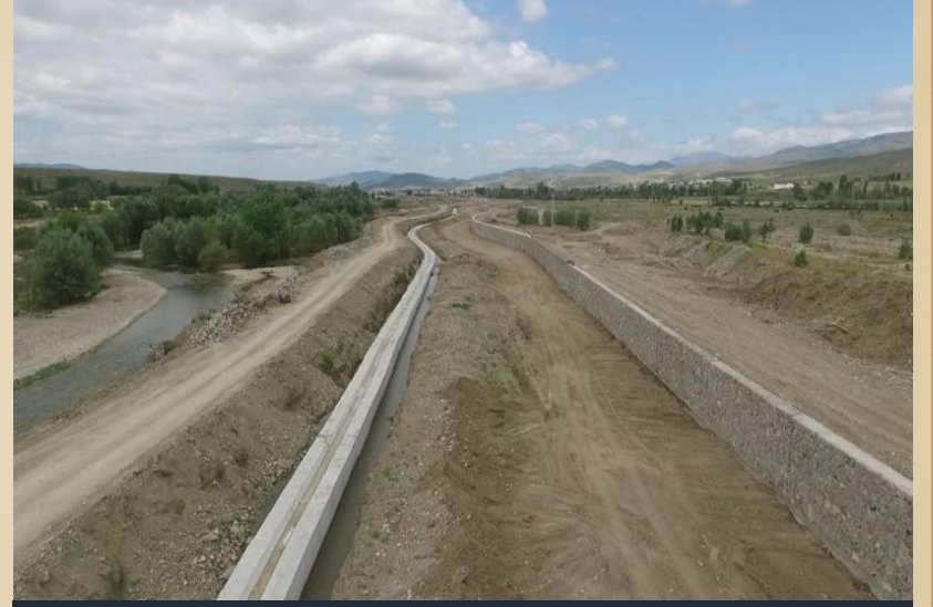
KELKİT İLÇE MERKEZİ VE ARAZİLERİ 2. KISIM TAŞKIN KORUMA İNŞAATI
