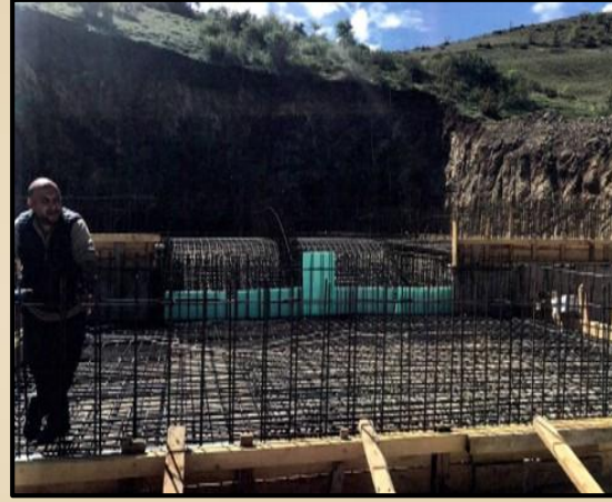
DEREDOLU İÇME SUYU
