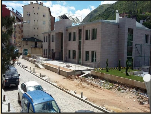
GÜMÜŞHANE GENÇLİK MERKEZİ İNŞAATI
