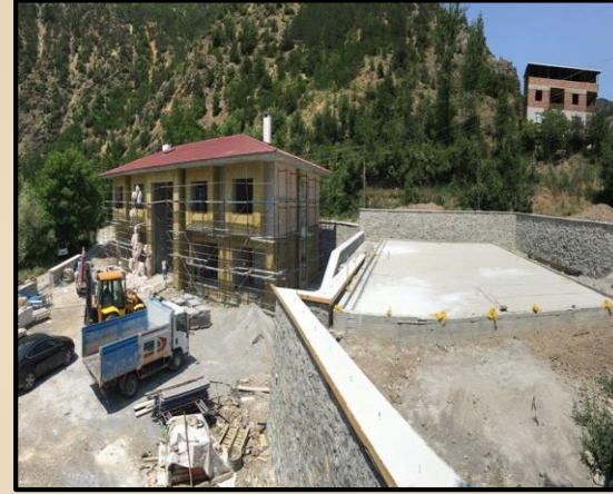
TORUL GENÇLİK MERKEZİ YAPIM İŞİ
