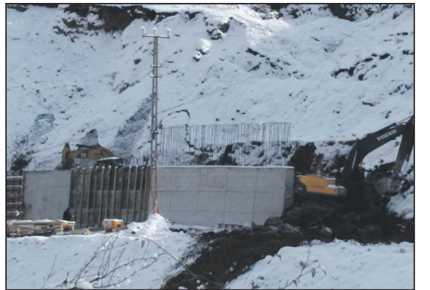
Görsel 4: Betonarme İstinat Duvarları
